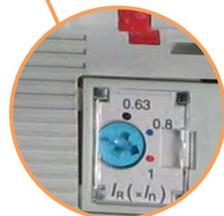
→ Регулировка тепловой защиты в пределах 0,63-1 x I<sub>n</sub>
